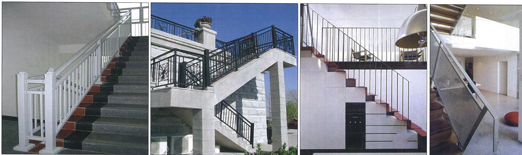
室内楼梯栏杆栏板
